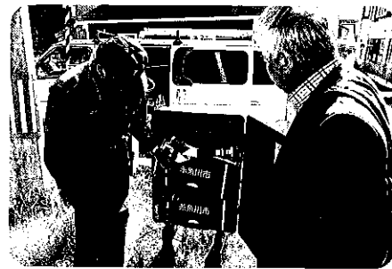
初期消火用40mmホース
