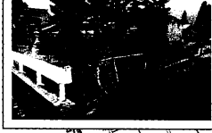
VI-2(4)中江川 (転落防止柵補修)
