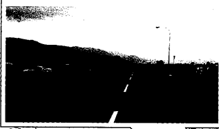
II-2 井波軸屋地内死亡事故交差点 (白線表示等の設置)
